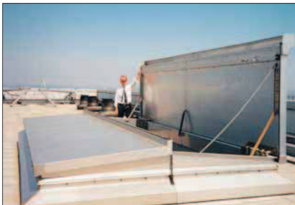
Se muestra aquí el Tipo D - Escotilla de Techo de Doble Hoja
